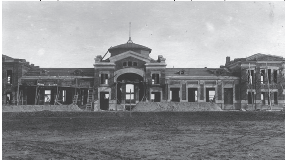
Идет строительство старого вокзала
